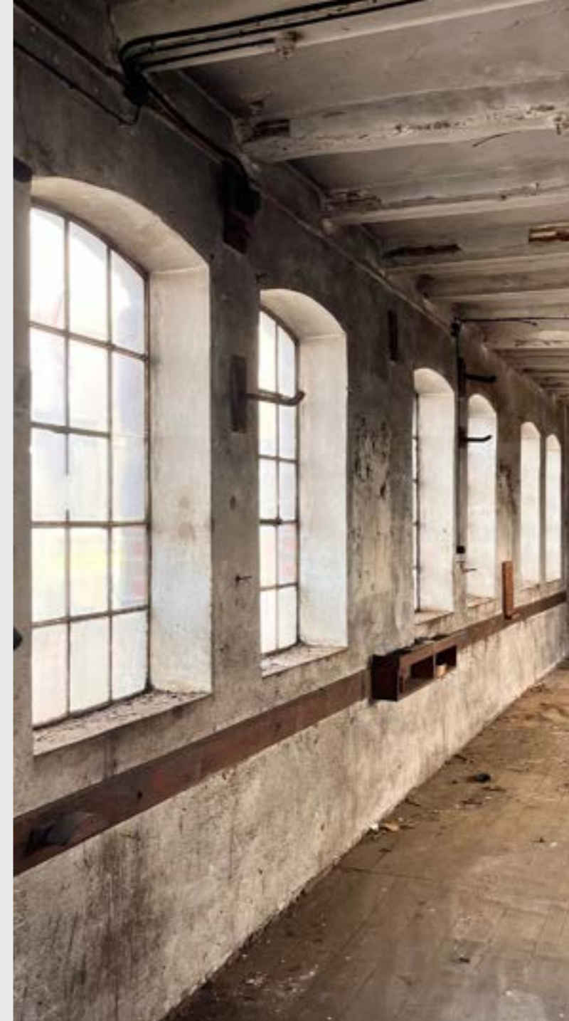
Fabrikhalle in der ehemaligen Mühlenbau-Anstalt.
