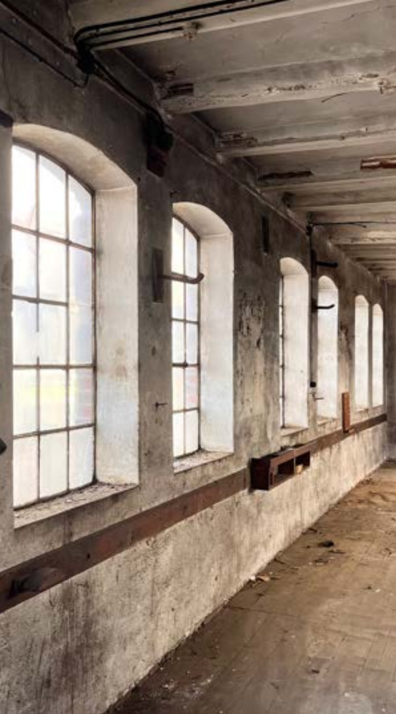
Fabrikhalle in der ehemaligen Mühlenbau-Anstalt.
