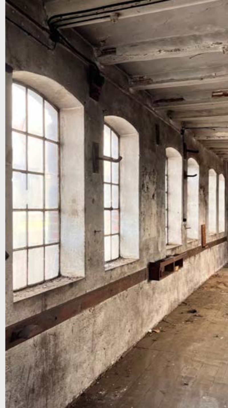
Fabrikhalle in der ehemaligen Mühlenbau-Anstalt.
